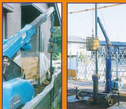
ミニクレーンによる施工
