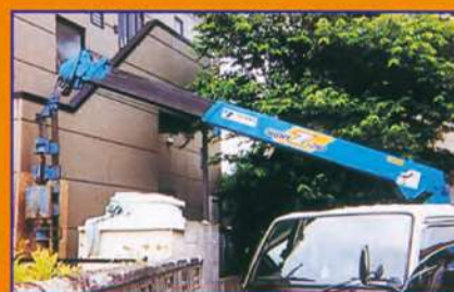
ユニックによる施工
