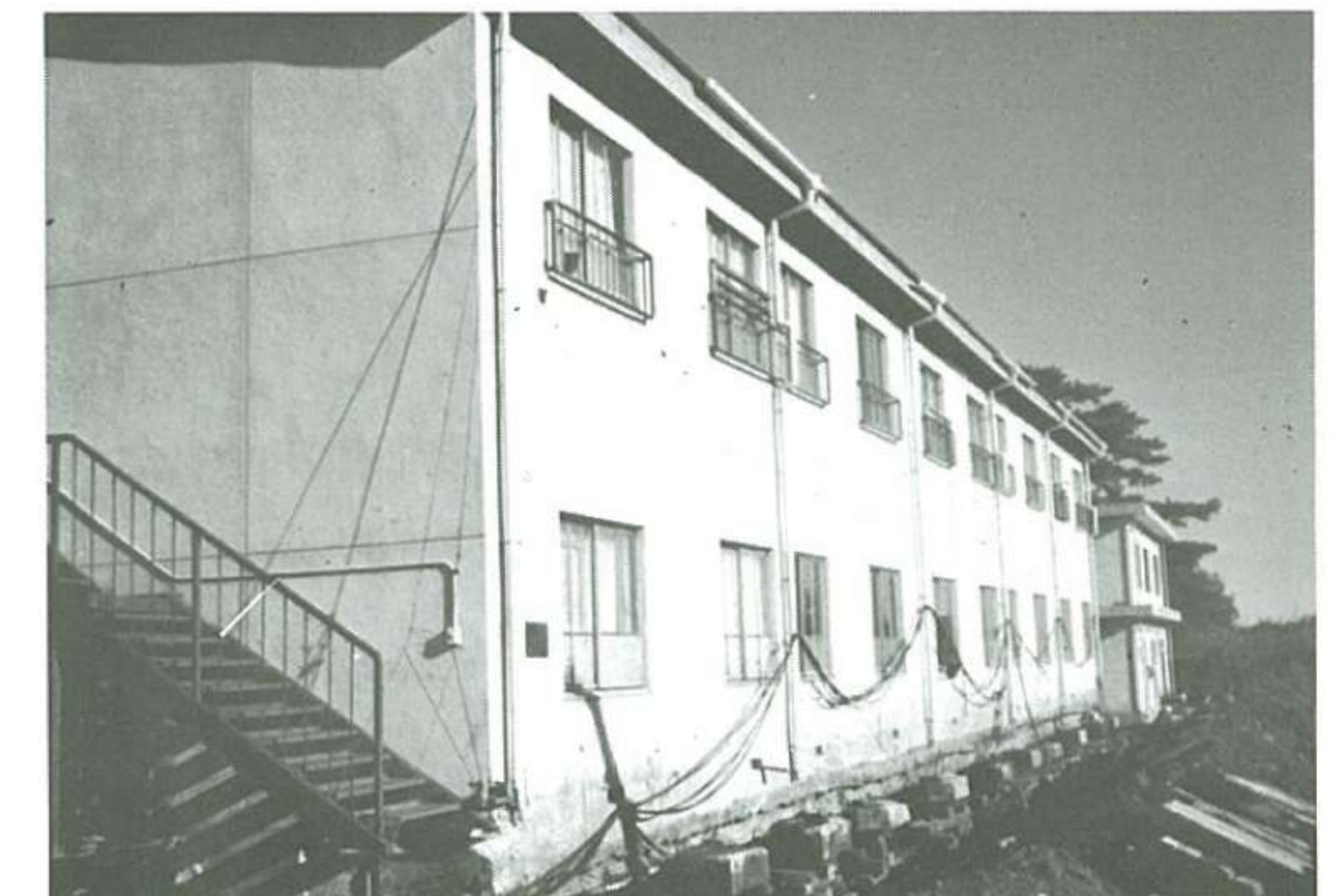
▲RCアパート・24世帯 居住のまま移動 45M 800㎡
