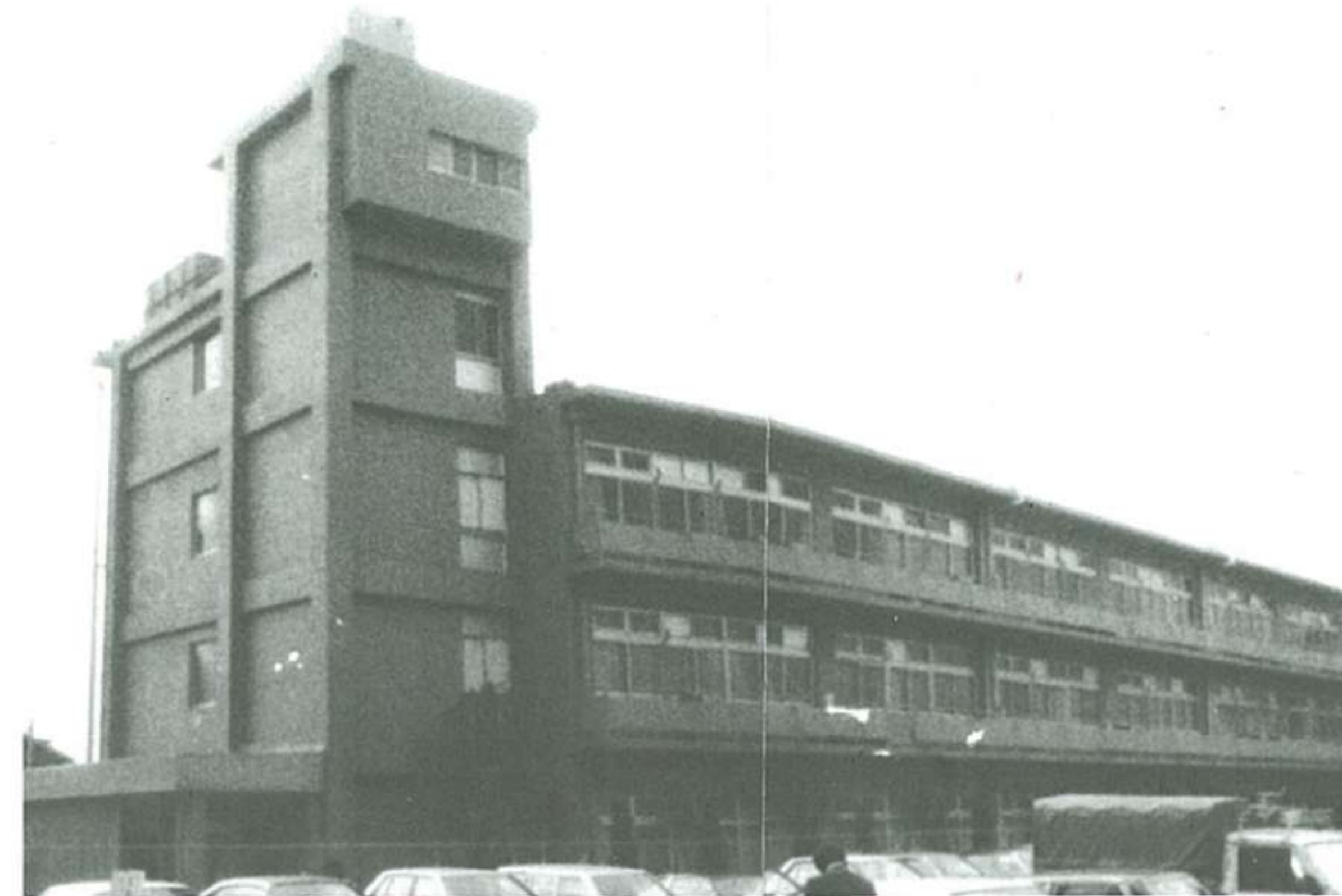
▲大宮日赤病院病棟移動工事 延1,350㎡ 30m斜移動
