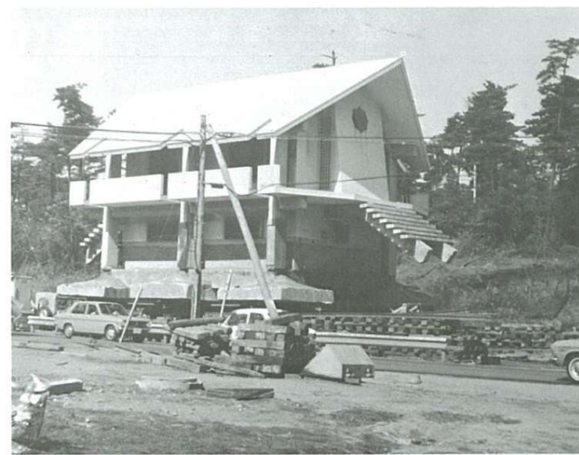
▲千葉市・圓生弁財天本堂（RC）移動 国道16号横断120M 48坪
