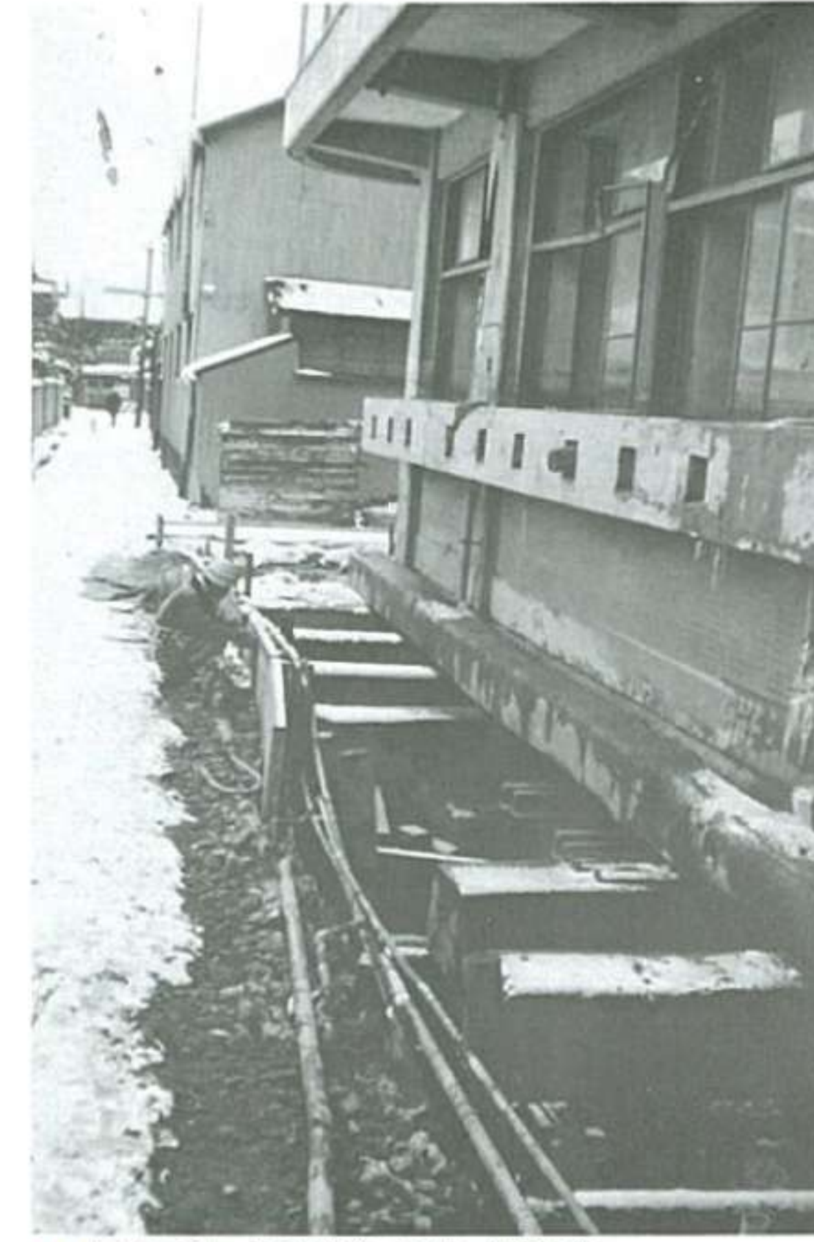
▲上梁工法(BH杭)R4F 新潟市
