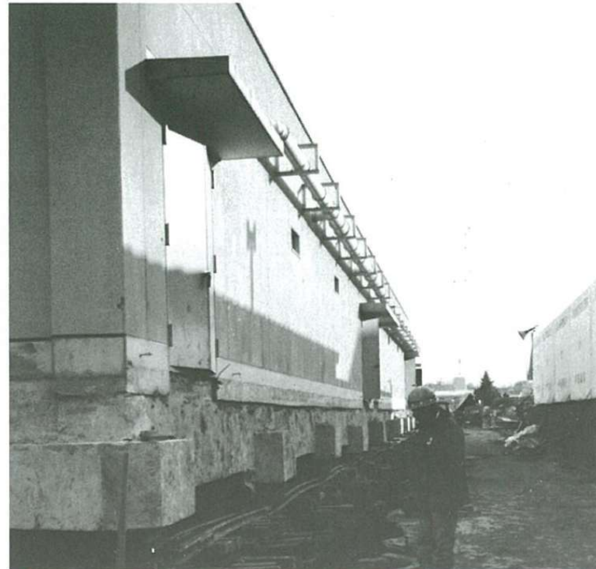
▲福島県須賀川市RC倉庫 移動100M 延600㎡
