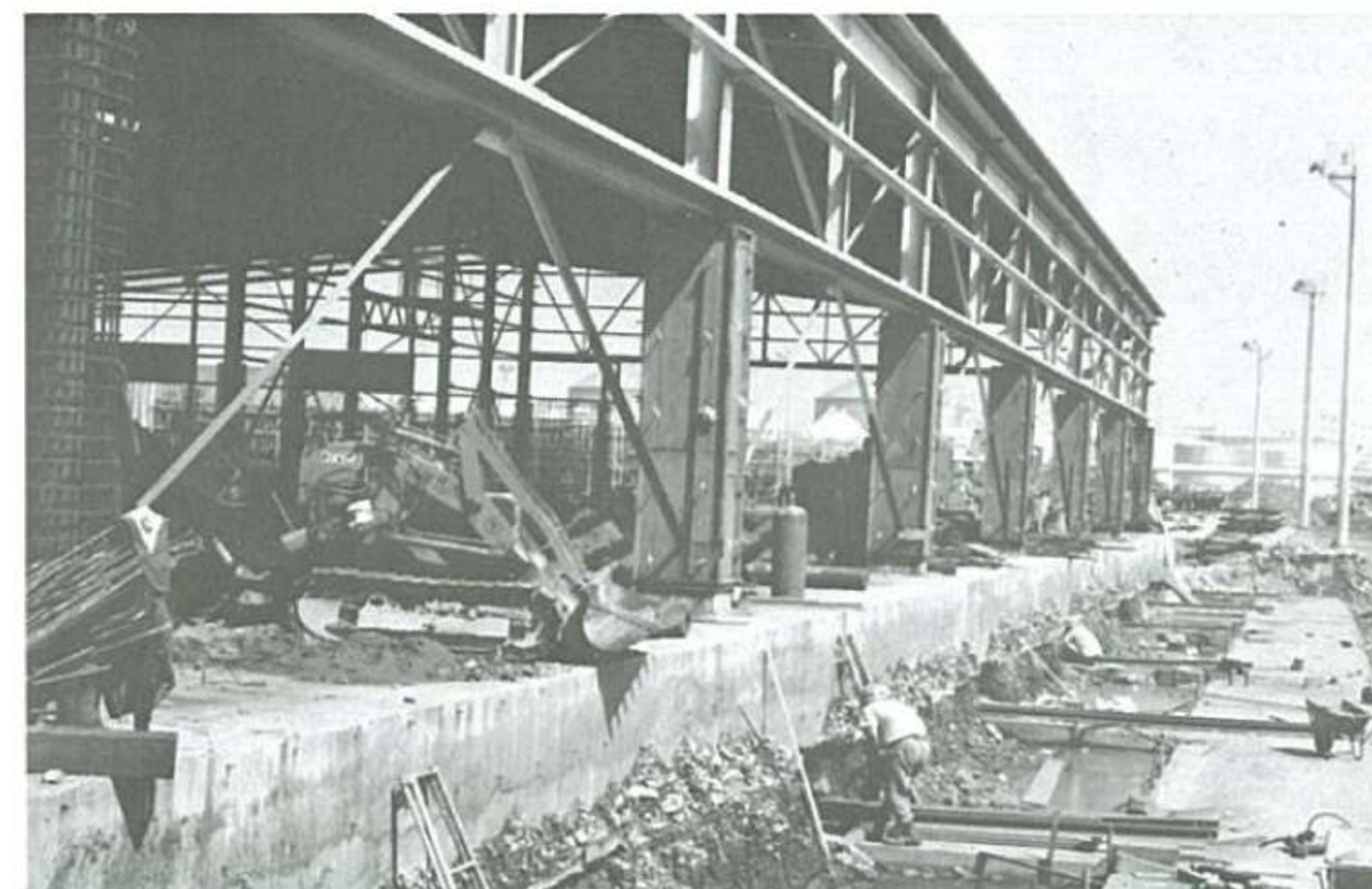
▲川崎日本鋼管鉄骨倉庫 移動10M 6400㎡
