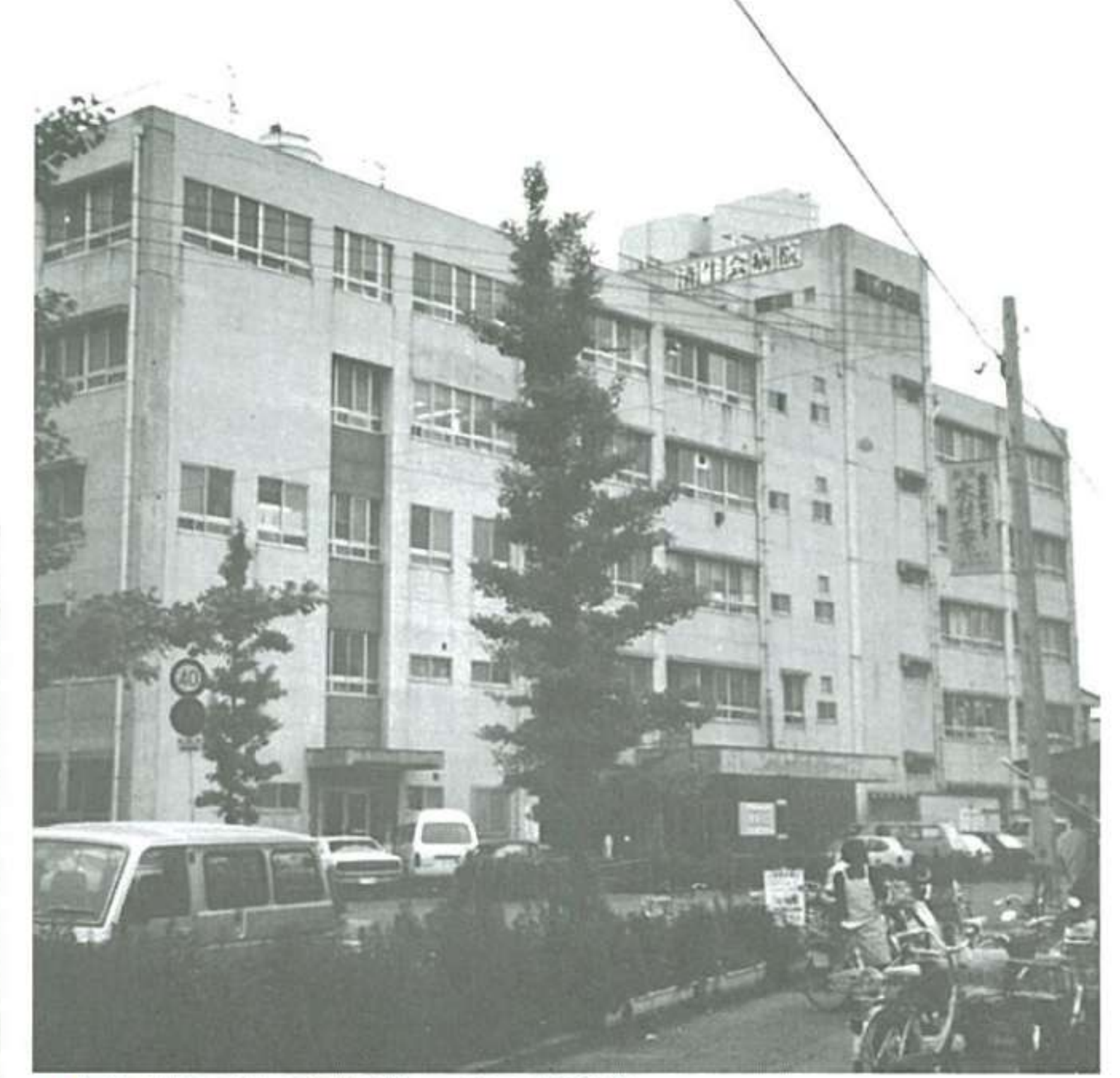
▲直接支持工法(鋼管杭)RC5F 新潟県
