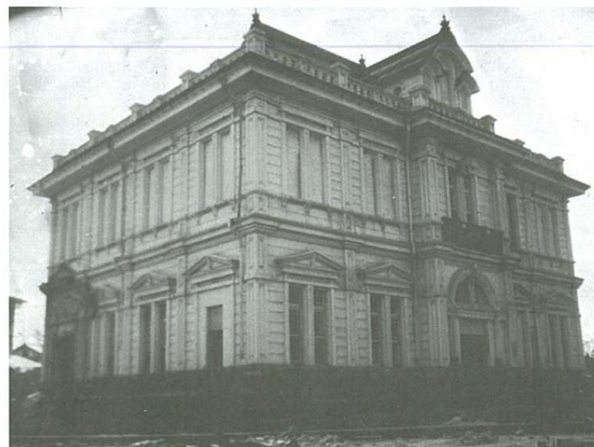
▲弘前市青森銀行 永久保存の為移動（重要文化財）斜移動50M 回転90度 延825㎡
