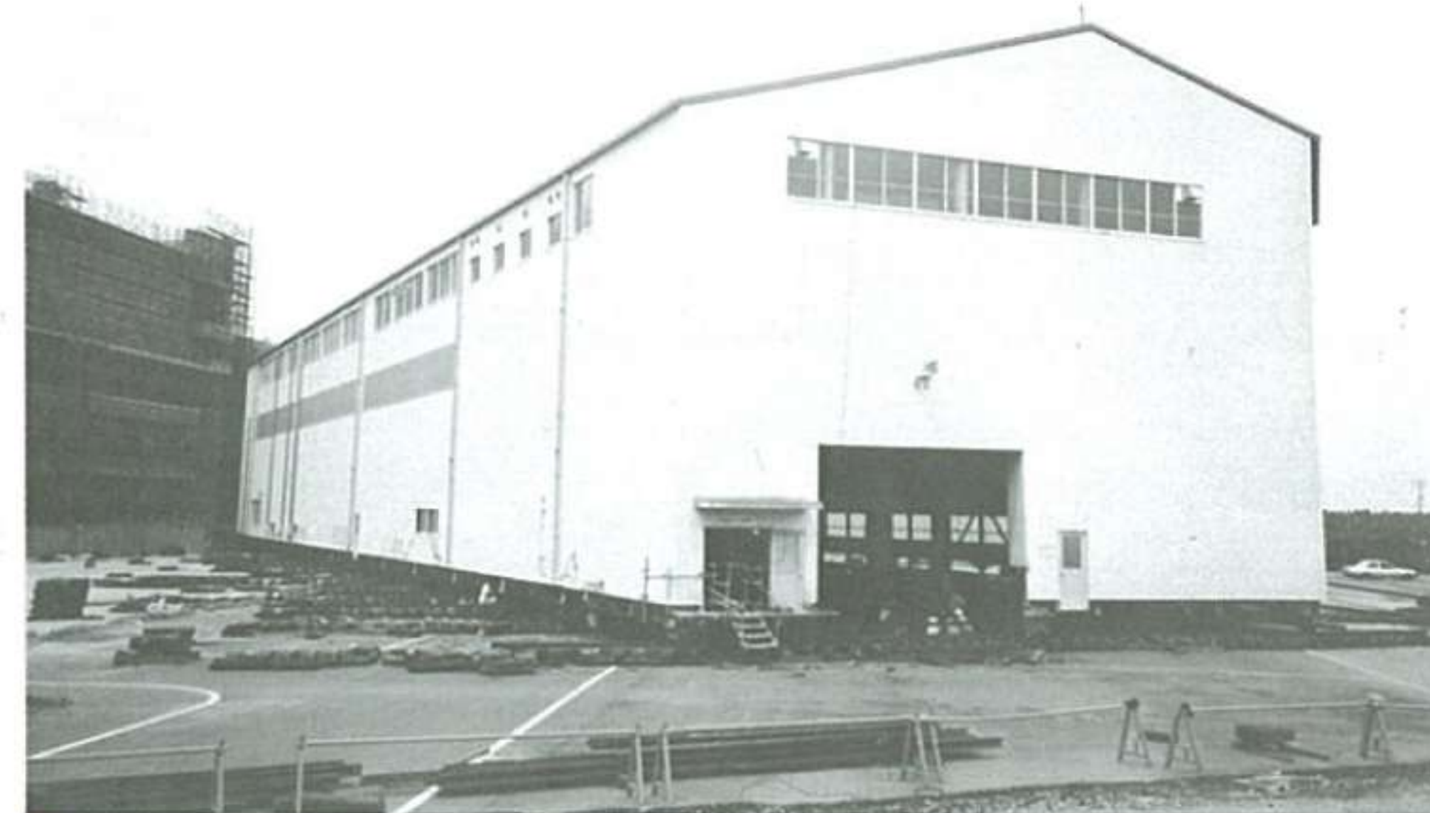
▲横浜市金沢区鉄骨3階建1階倉庫2~3階事務所 延7,500㎡ 回転90° 移動300M
