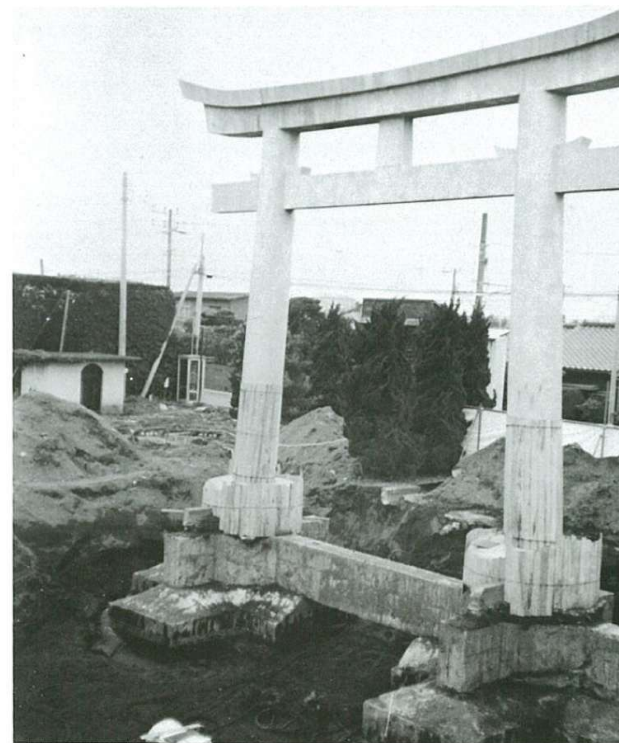
▲千葉県館山護国八幡神社 250t 高さ13M 斜移動10M
