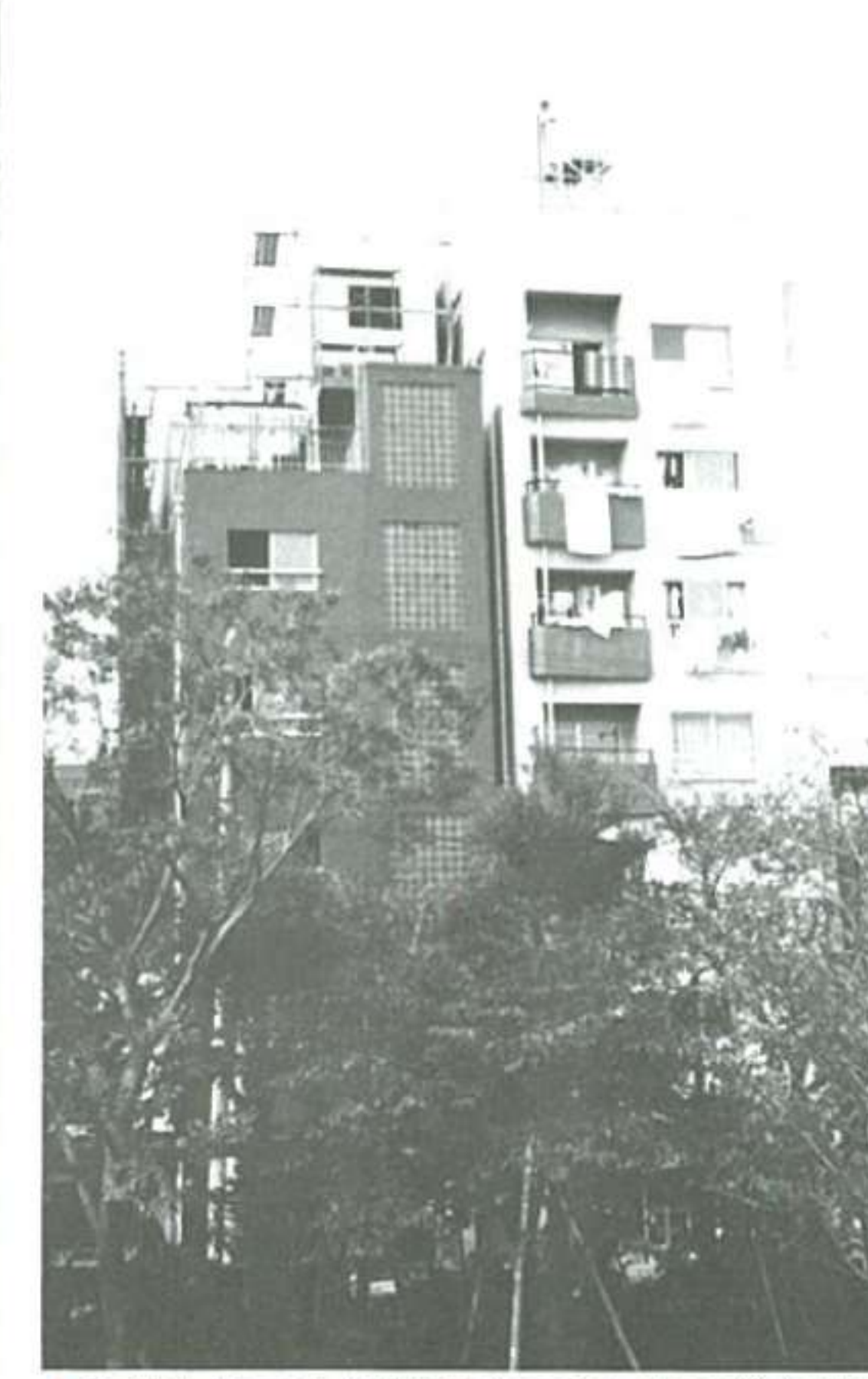
▲直接支持工法(鋼管杭)RC7F 東京都台東区
