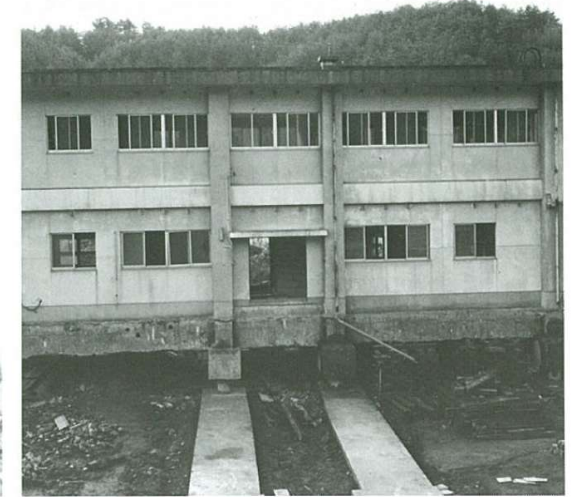
▲島根県立大田高校校舎移動工事 延648㎡
