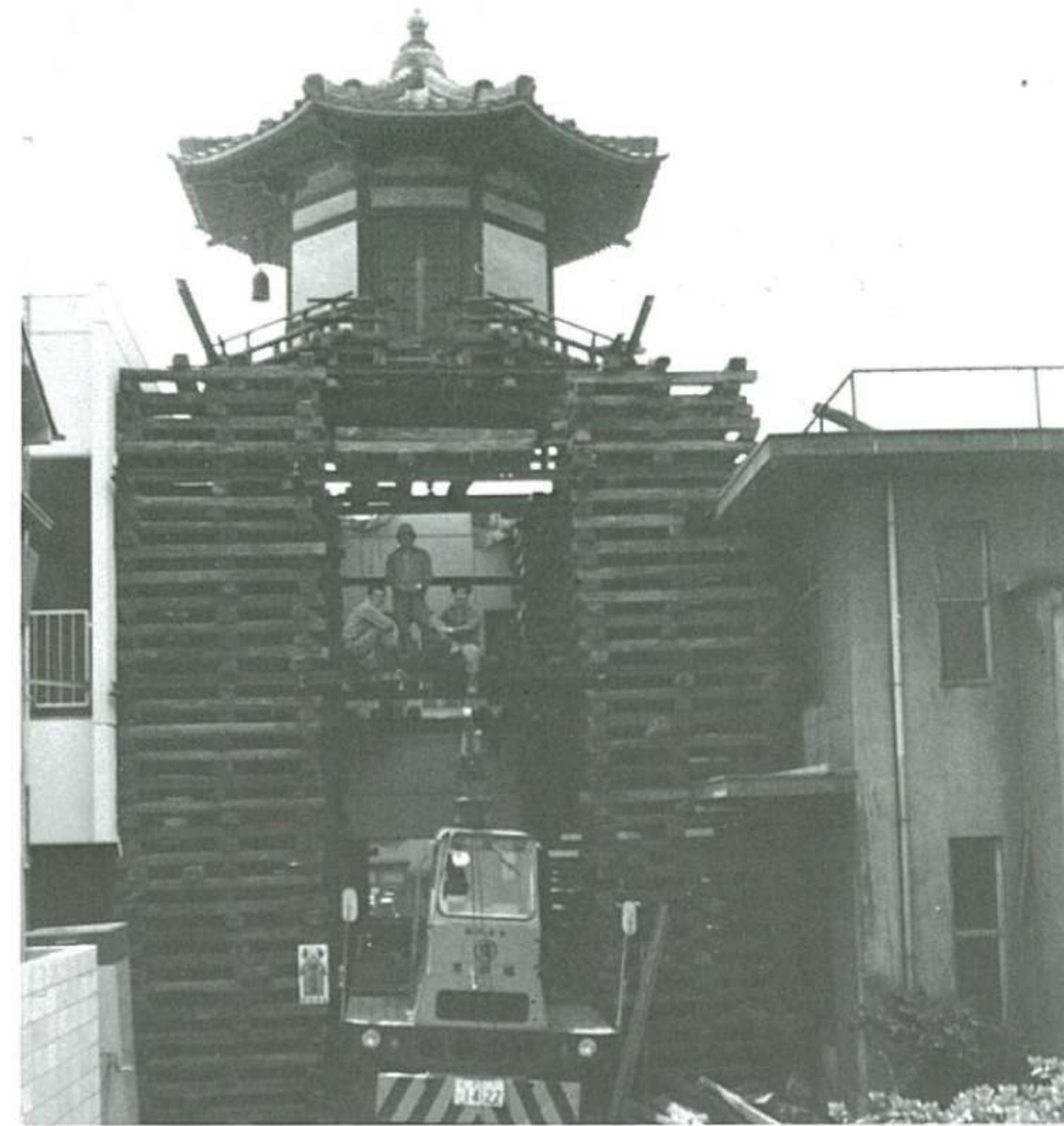
▲国宝・御堂をRC新築の2階へ移動（高低差8M）
