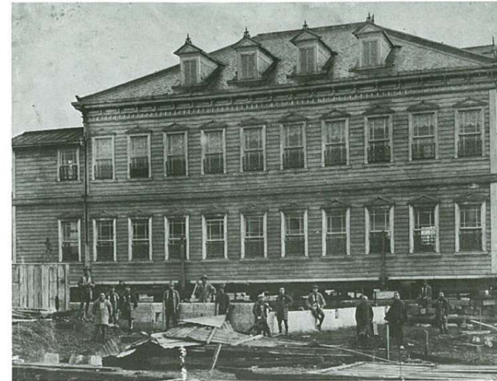
▲東京毛織会社 移動工事 約50M・回転45°・延180坪 大正12年4月
