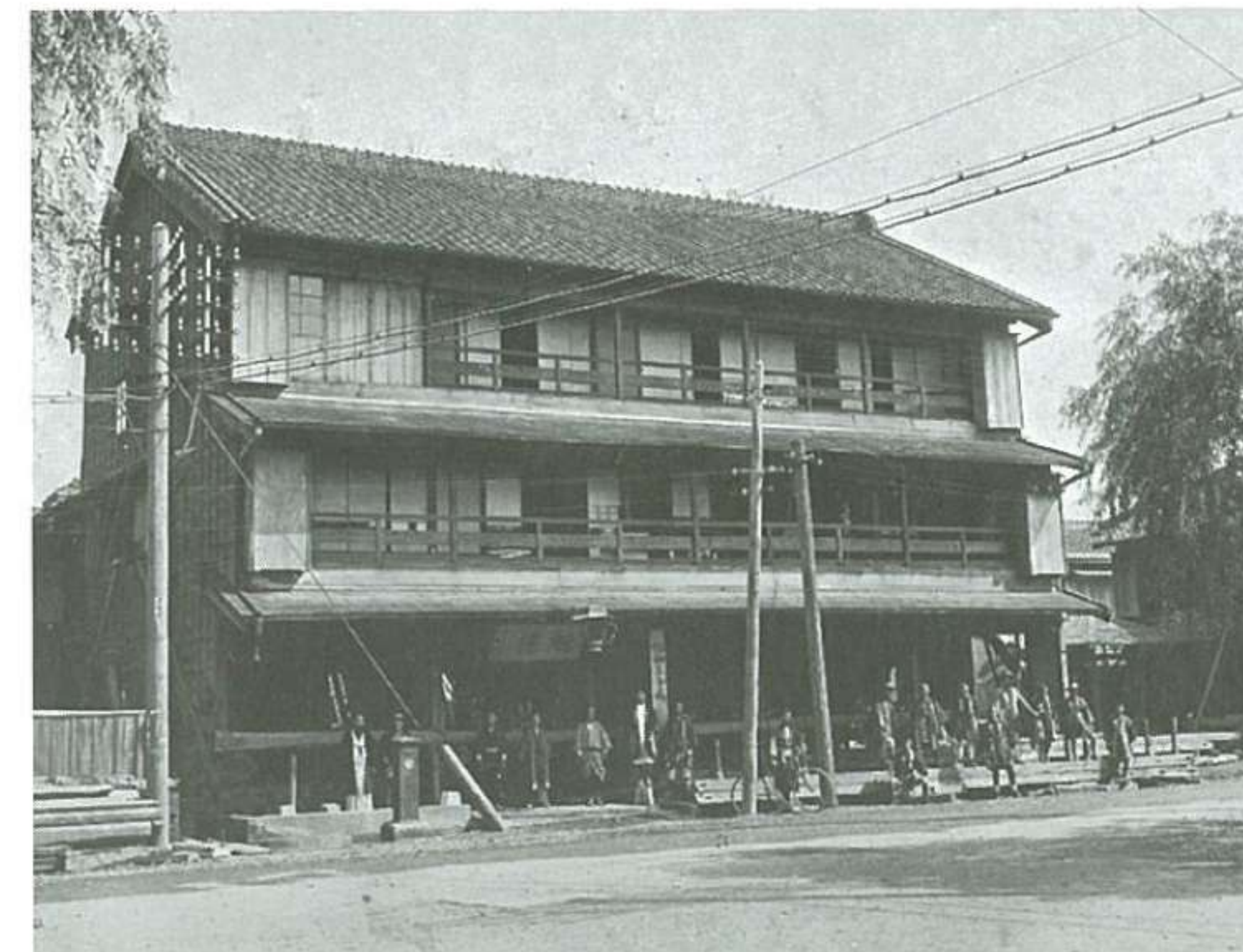
▲神田錦町旅館旭楼 移動工事 約20M 延155坪 明治28年7月
