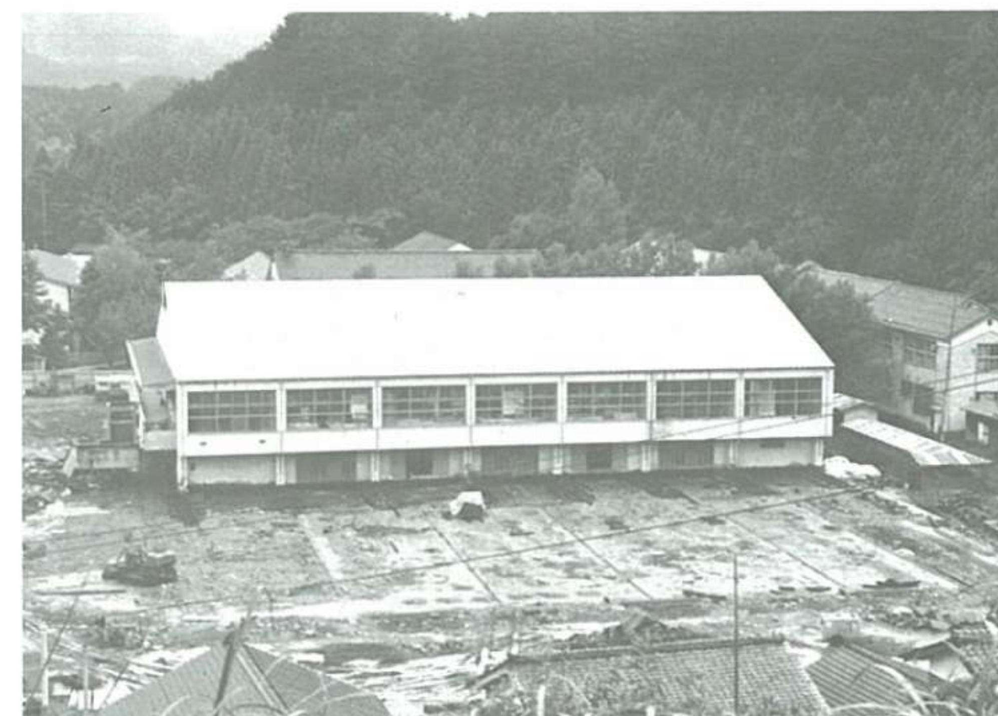
▲島根県隠岐高校体育館・俯瞰撮影 延1,500㎡ 50M移動
