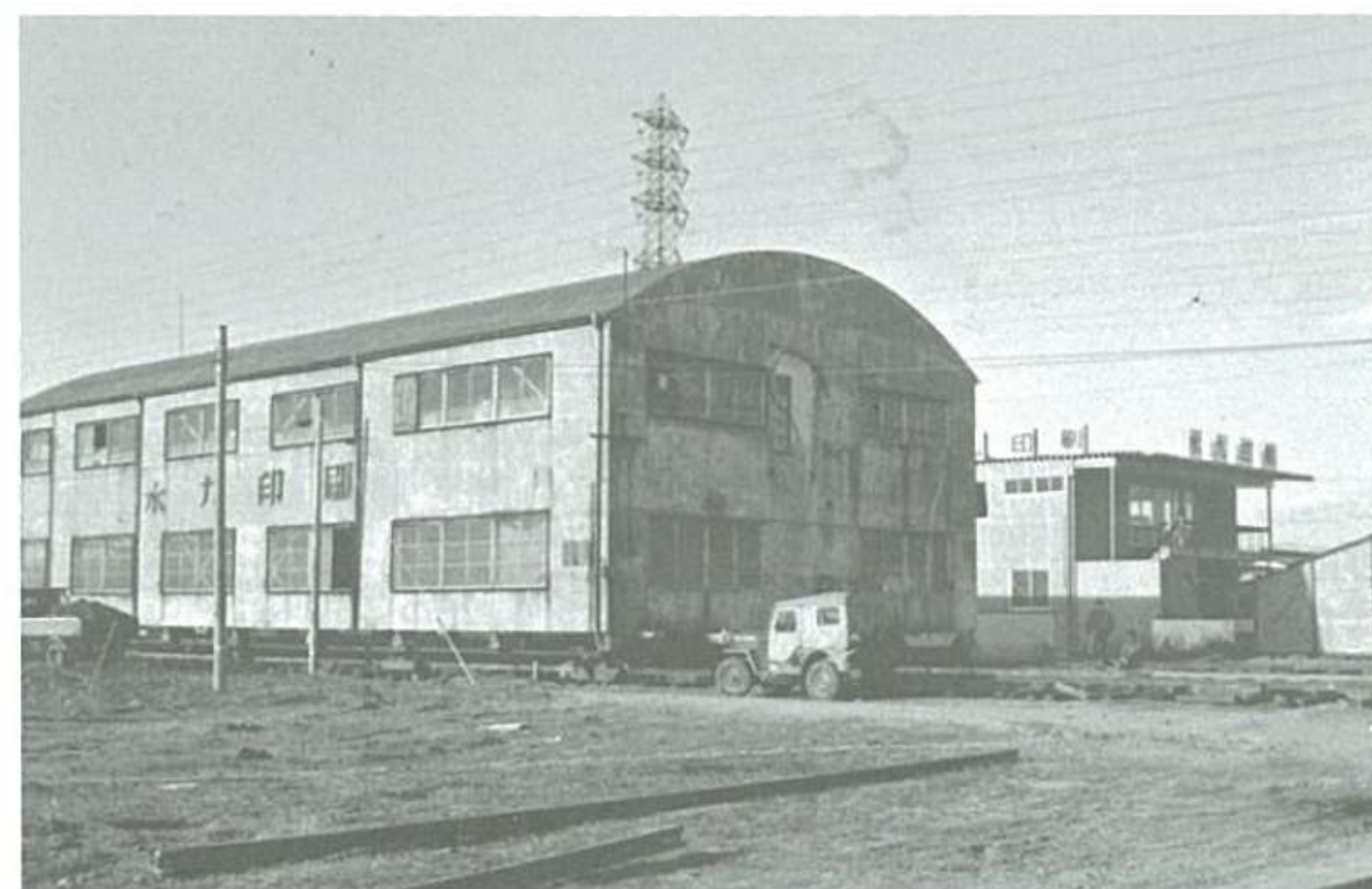
▲四日市鉄骨工場 移動750M
